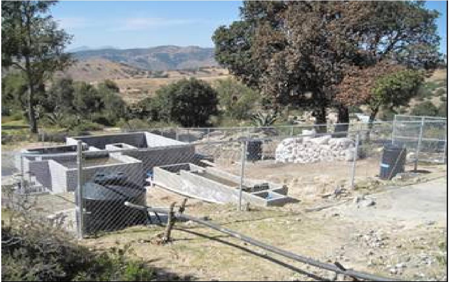
Vista panorámica de la potabilizadora demostrativa FIME de Peregrina. A es el tanque de regulación de descarga, C, es el Filtro Grueso Dinámico descendente (FGDi), B el Tanque dosificador de coagulante del FGDi; D, Filtro grueso ascendente en serie 1 (FGAS1); E Filtro grueso ascendente en serie 2 (FGAS2); F, Filtro lento de arena (FLA) y G, Dosificador y aplicación de cloro en salida del FLA
