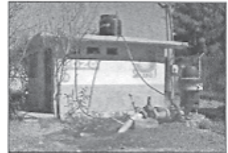
Pozo No. 2 "Victoria"
