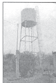
Tanque Elevado No. 3 Jaral
