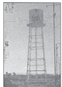
Tanque Elevado No. 4 Jaral
