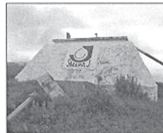
Tanque Superficial No. 2 Capitiro
