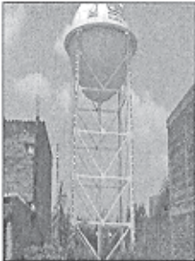
Tanque Elevado No. 1 Jaral
