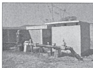
Pozo No. 2 "Santa Elena"
