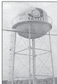
Tanque Elevado No. 2 Jaral
