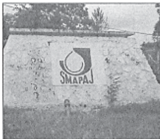
Tanque Superficial No. 1 Capitiro
