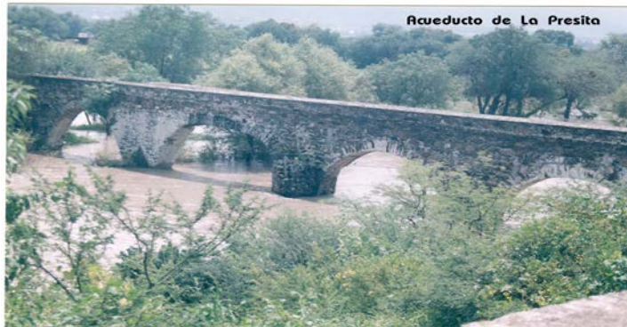
Acueducto de la Presita. Foto: Archivo de Francisco Sauza Vega
