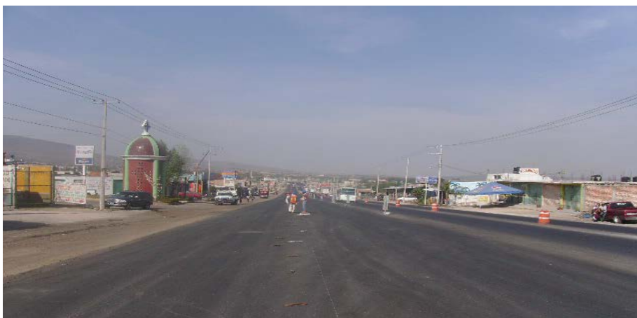
Modernización de la Carretera panamericana Fotografía: Archivo de Francisco Sauza Vega
