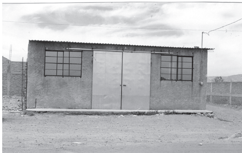
Fotografía del TEMPLO DE LA IGLESIA PENIEL, cuando estaba en construcción.
