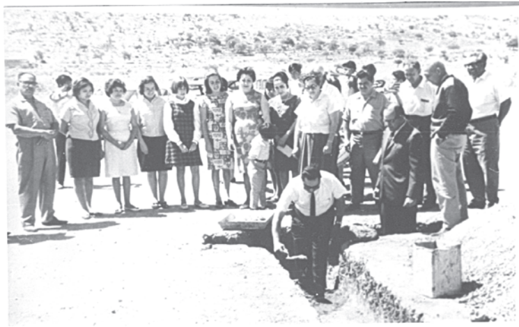
Fotografía que muestra el momento en que el DR. RAFAEL RIVBERA RIVERA, está colocando la primera piedra de lo que sería la ESCUELA SECUNDARIA VIRGILIO URIBE.
