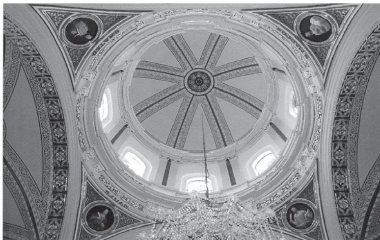
Fotografía que muestra a la cúpula de la parroquia, con toda su restauración completa.
