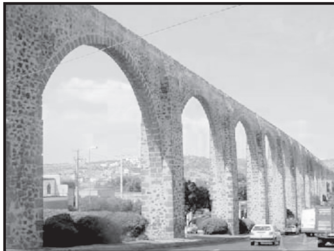
ACUEDUCTO EN QUERÉTARO
