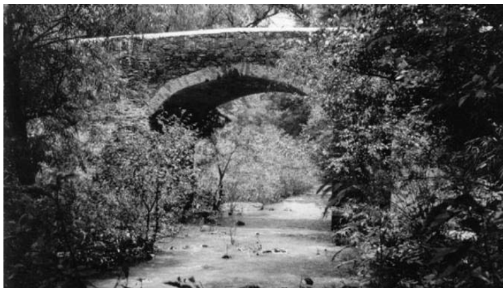
CONSTRUCCIÓN DE CANTERA NEGRA SOBRE EL RÍO TIGRE.
