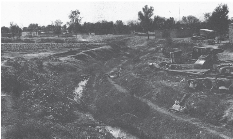
Todavía en 1969 el río Silao –ahora Blvd. Díaz Ordaz- representaba un serio peligro para la salud de la población debido a encharcamientos, muladares y tabiqueros instalado todo, en su cauce y orillas.
