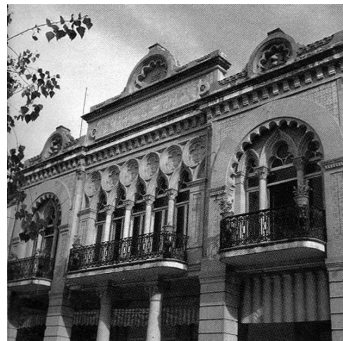
Edificio del Portal Aldama
