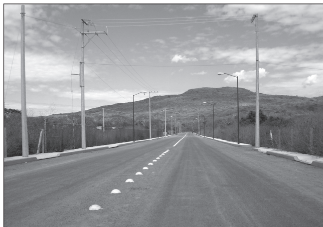
ACCESO AL HOSPITAL COMUNITARIO DE PRÓXIMA CONSTRUCCIÓN.
