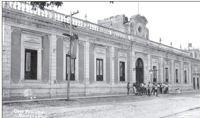
FACHADA DE LA PRESIDENCIA MUNICIPAL.
