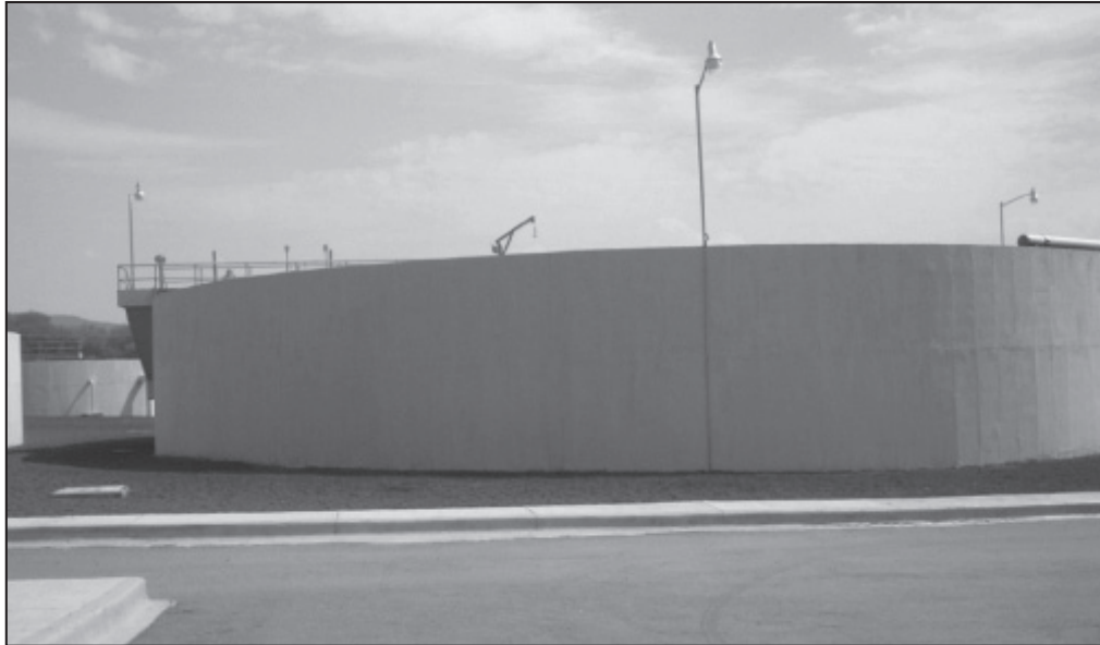
TANQUE CONTENEDOR DE AGUAS RESIDUALES.
