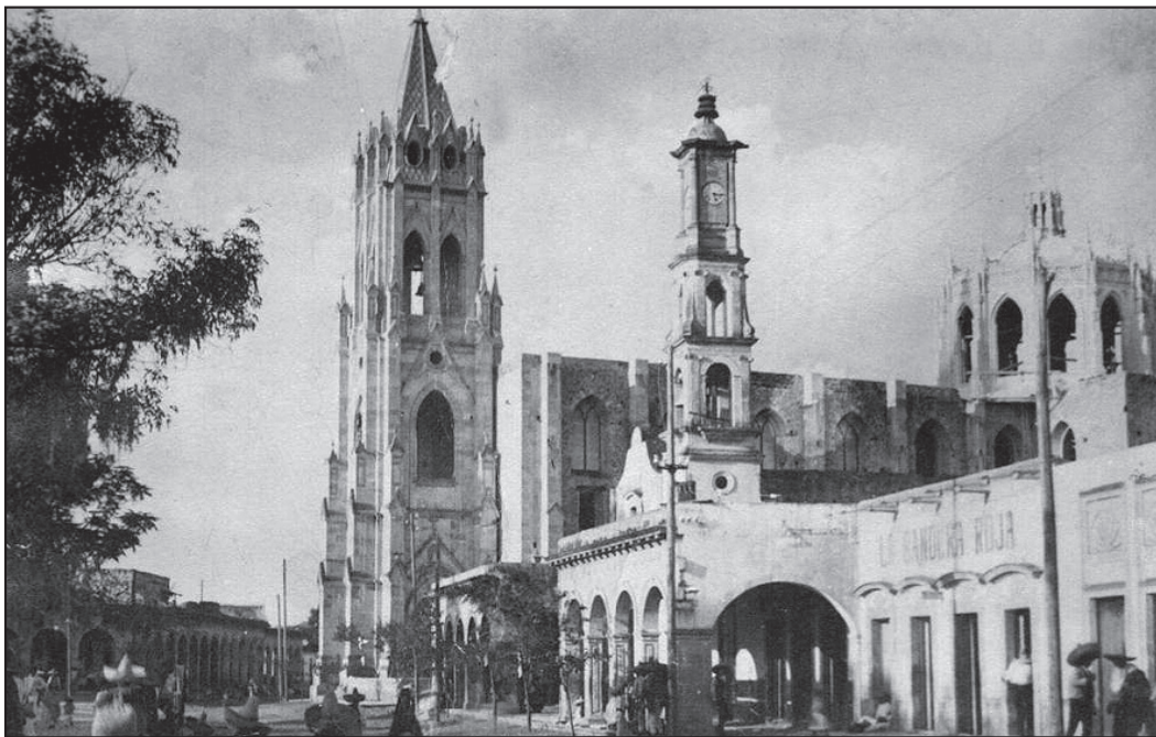
EN ESTA FOTOGRAFÍA SE APRECIA LA TORRE QUE TENÍA LA CAPILLA DE LA VIRGEN DE LA SOLEDAD, TORRE QUE NO ESTABA SOBRE EL PORTAL CUYO TRAMO AÚN NO SE CONSTRUÍA.
