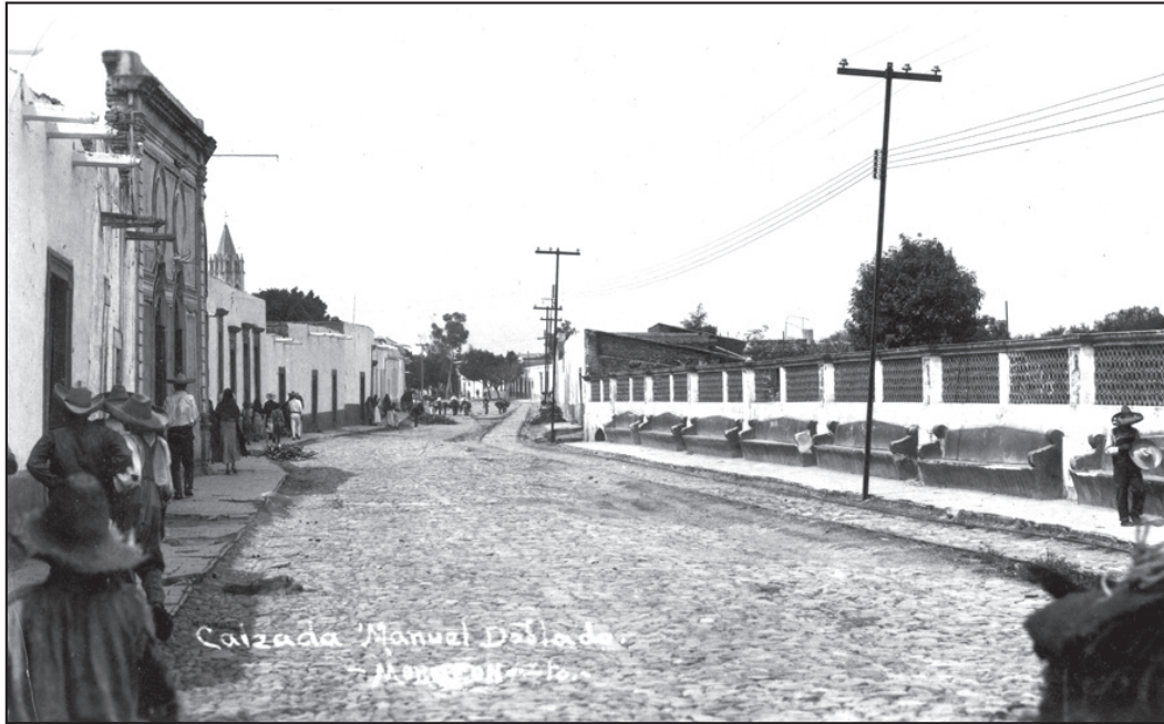
CALZADA MANUEL DOBLADO, A LA IZQUIERDA SE APRECIA EL EDIFICIO DONDE LA GENTE PAGABA EL SERVICIO DE LUZ.
