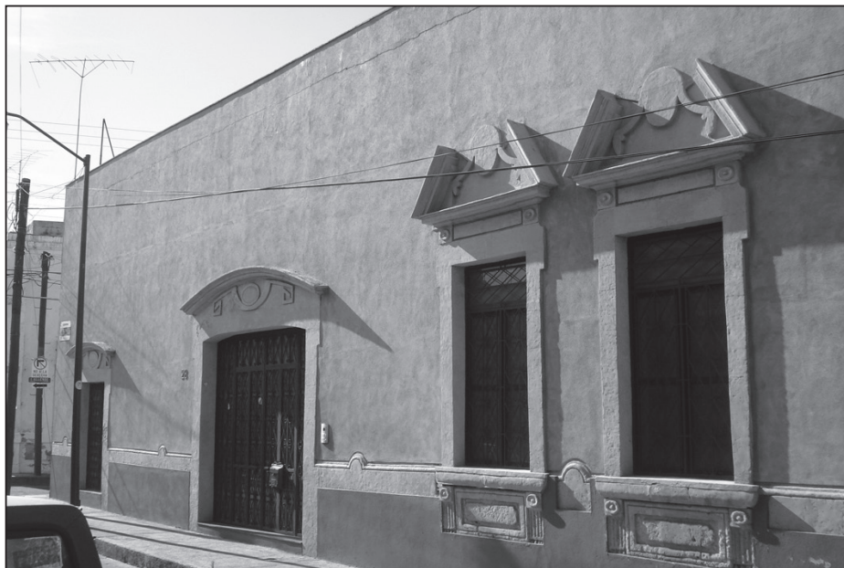
CASA RESTAURADA. (ESQUINA CALLE DEL TESORO CON ALLENDE).
