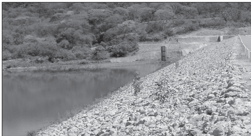
PRESA DE CEPIO DE CONTROL DE AGUAS PLUVIALES.
