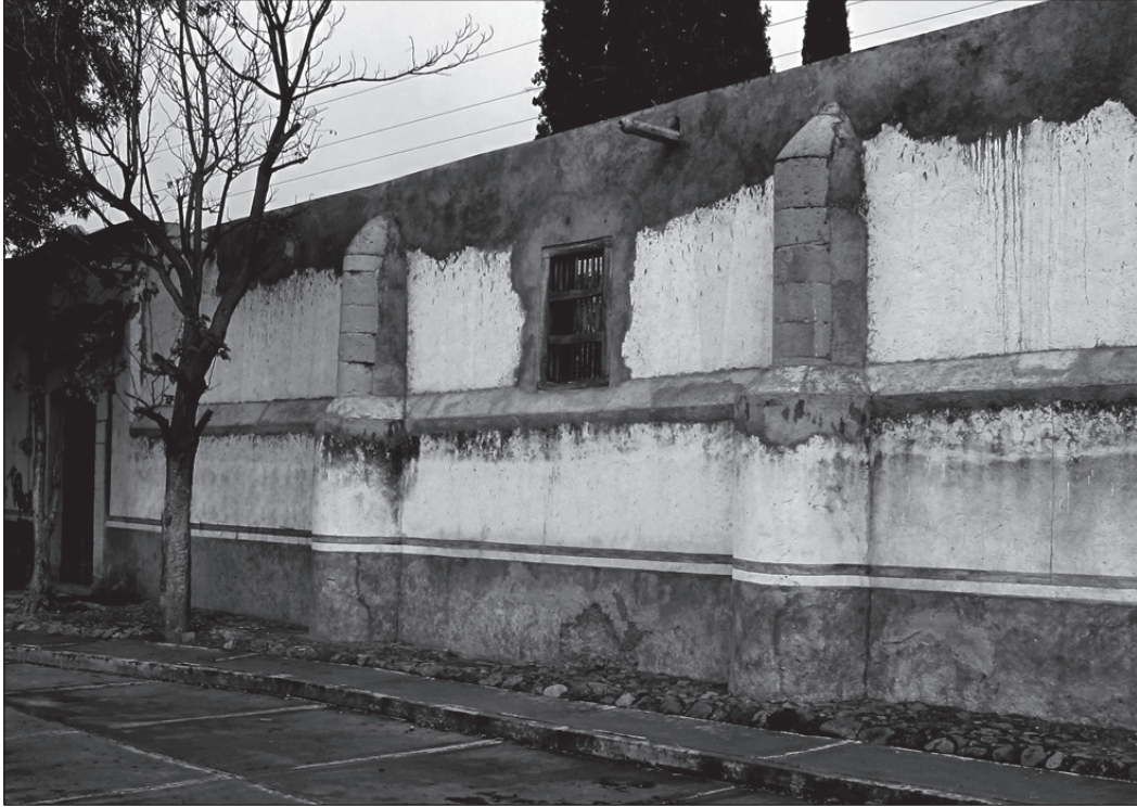
BARDA EN UNA FINCA DE CEPIO, MOROLEÓN DEL SIGLO XVIII QUE MUESTRA LAS PILASTRAS O CONTRAFUERTES QUE REFORZABAN ESAS CONSTRUCCIONES DE LA ÉPOCA.
