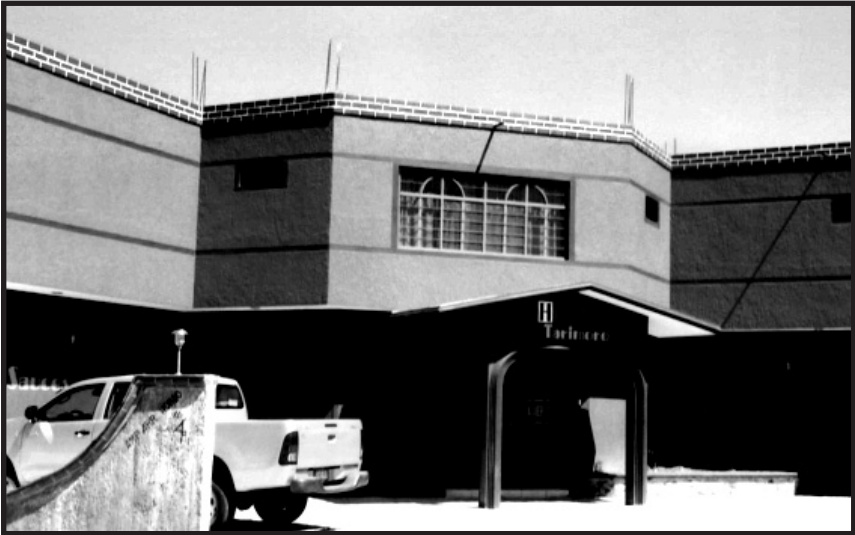
- HOTEL TARIMORO UBICADO SOBRE LA CARRETERA A ACÁMBARO -
