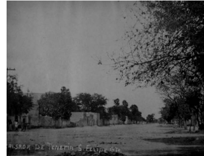
CALZADA DE LA TENERÍA 1920 (ACTUALMENTE 5 DE MAYO)
