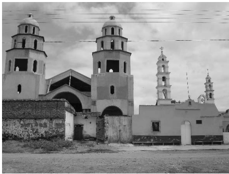
ANTIGUO TEMPLO Y TEMPLO EN COSTRUCCIÓN DEL ARCANGEL SAN MIGUEL EN LA COMUNIDAD DE LA LABOR
