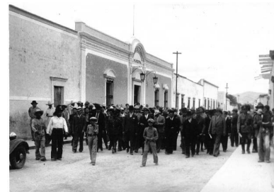
INAUGURACIÓN DEL HOSPITAL CIVIL EN LA CALLE DE 16 SEPTIEMBRE
