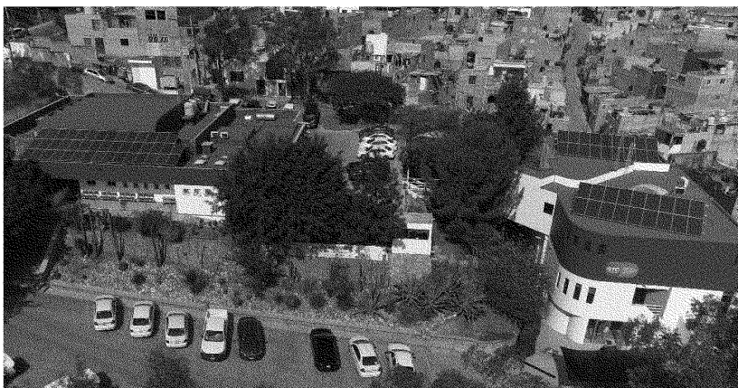
Figura 28. Instalación de sistema fotovoltaico en la Smaot, en el municipio de Guanajuato.
